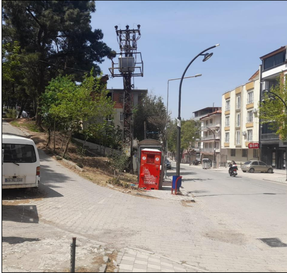
- Öneri Trafo Alanından Görüntü-
